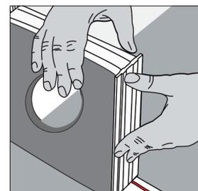
**8.** Kleben Sie das Profil vertikal an den Keramikstein. Dabei muss das kurze Profil auf dem langen aufliegen.
