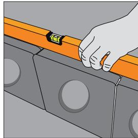
**11.** Nach der Montage der ersten Keramiksteinreihe überprüfen Sie mit der Wasserwaage ob die Reihe gerade ist. Solange der Kleber nicht angetrocknet ist, können Sie die Steine noch leicht bewegen. Beachten Sie die natürlichen Formschwankungen der Keramiksteine.
