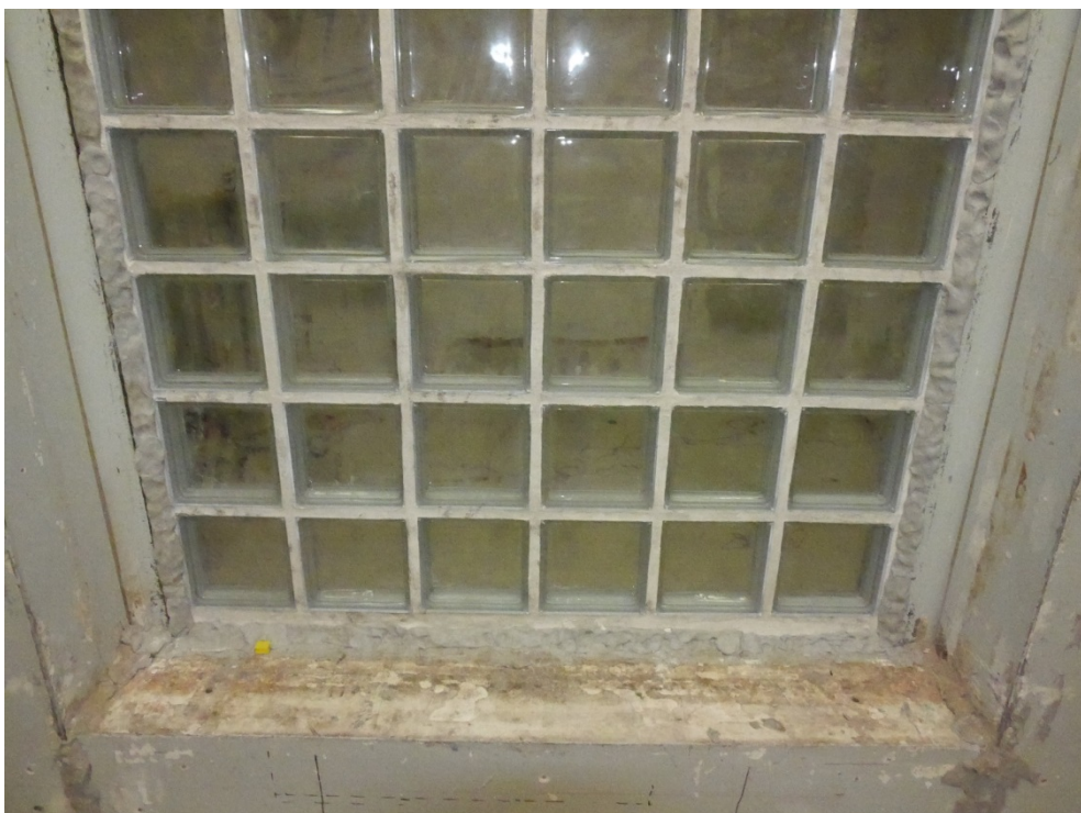
Abbildung B.6. Detailansicht senderraumseitig: Element im Prüfstand mit abgedichteten Anschlussfugen.
