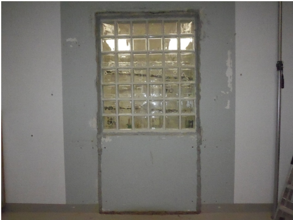
Abbildung B.2. Prüfaufbau im Fensterprüfstand: Gesamtansicht empfangsraumseitig.
