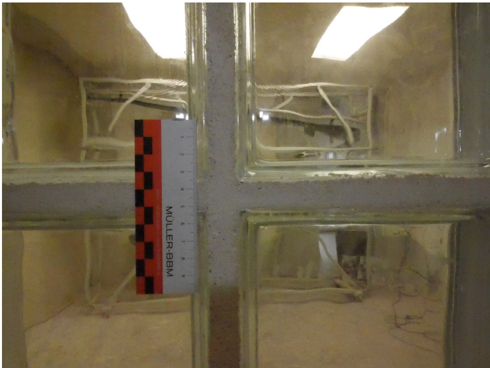
Abbildung B.5. Detailansicht: Ausbildung der Stoß- und Lagerfugen.
