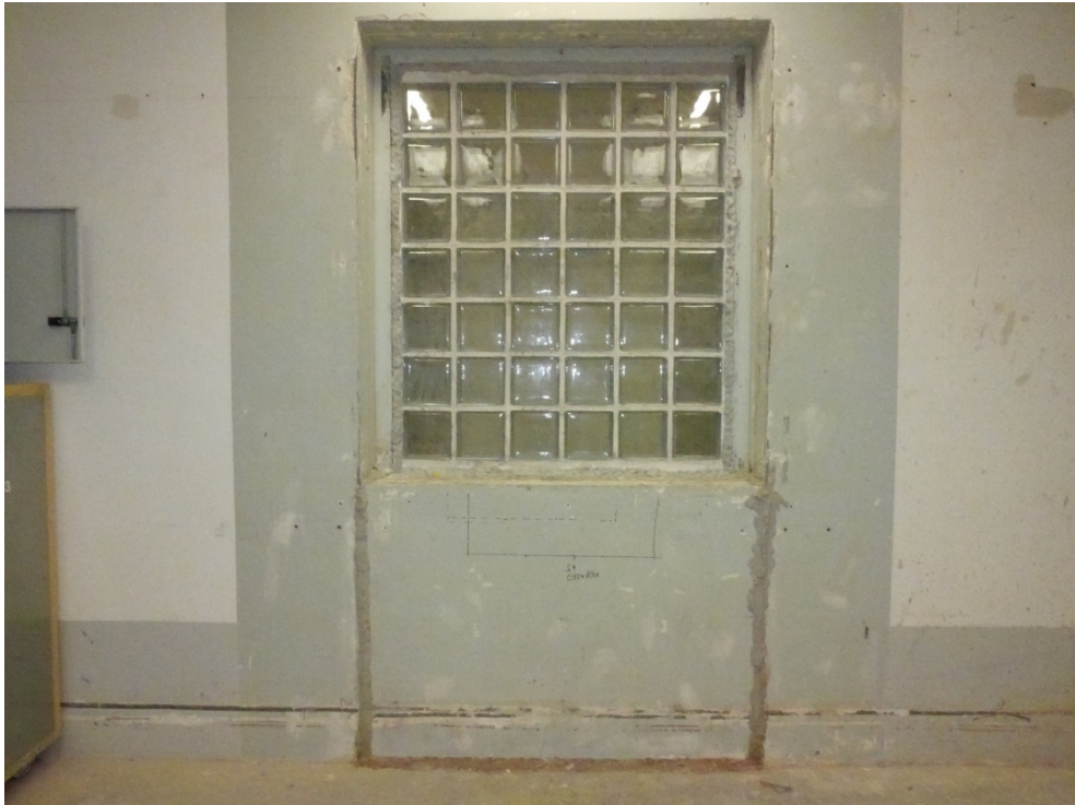
Abbildung B.1. Prüfaufbau im Fensterprüfstand: Gesamtansicht senderaumseitig.
