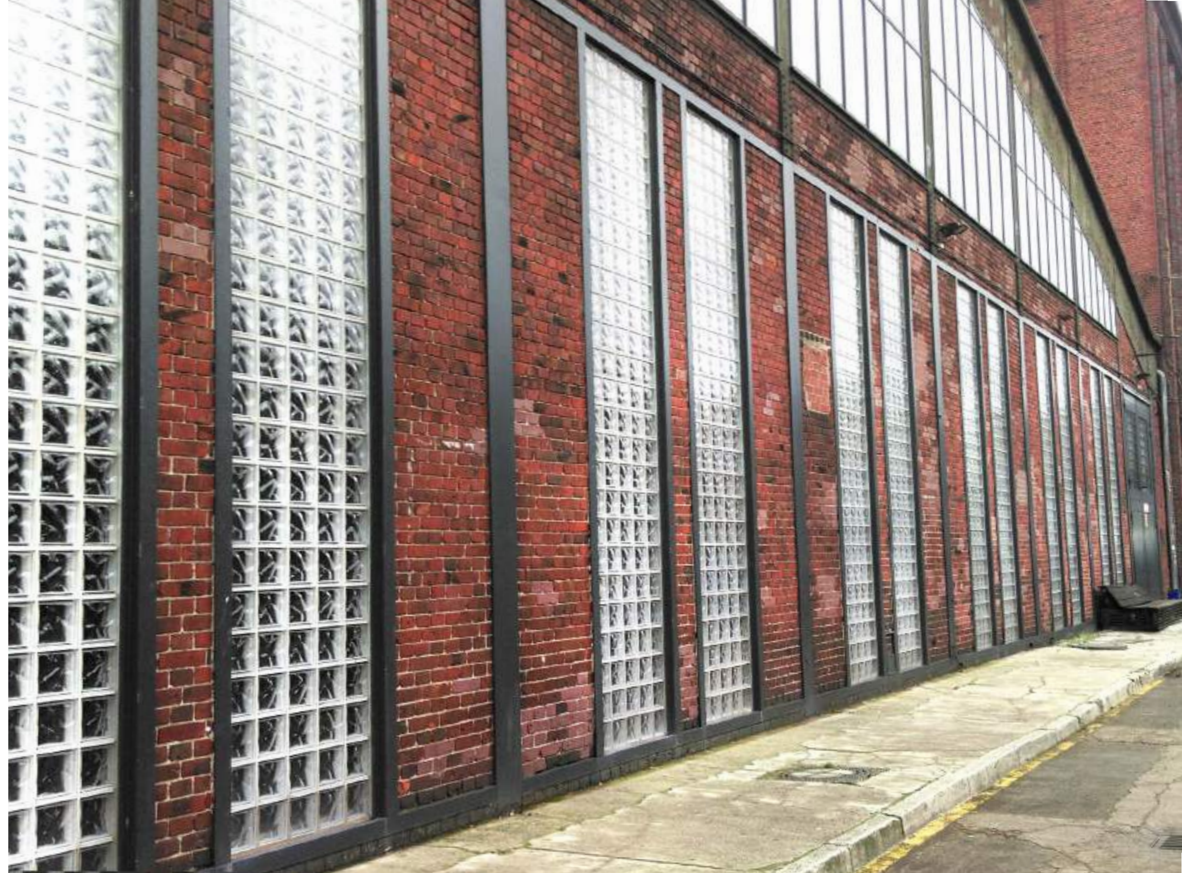
— Wolke, 19 x 19 x 8 cm, klassische Verlegung, Mörtel Denkmalgeschütztes Gebäude Außenfassade Berlin, Deutschland © Fuchs Design GmbH 2017
