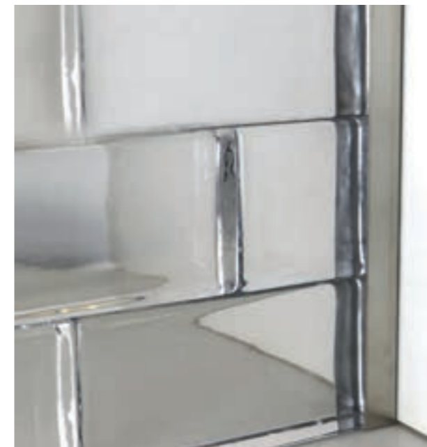
Collection Classic Glasziegel als Hochkantverlegung mit U-Profil
