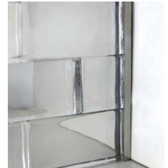
Collection Classic Glasziegel als Hochkantverlegung mit U-Profil
